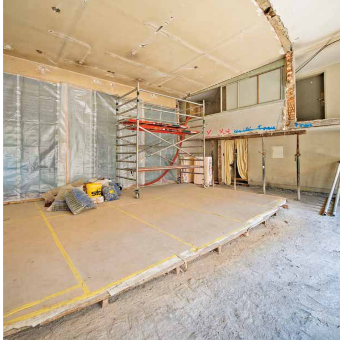
Der Parkettboden wurde so weit wie möglich erhalten und während der Bauzeit geschützt. In den Nischen unterhalb der Orgeltechnik sind eine Teeküche und Abstellräume für den neuen, multifunktionalen Bühnenraum geschaffen worden.
