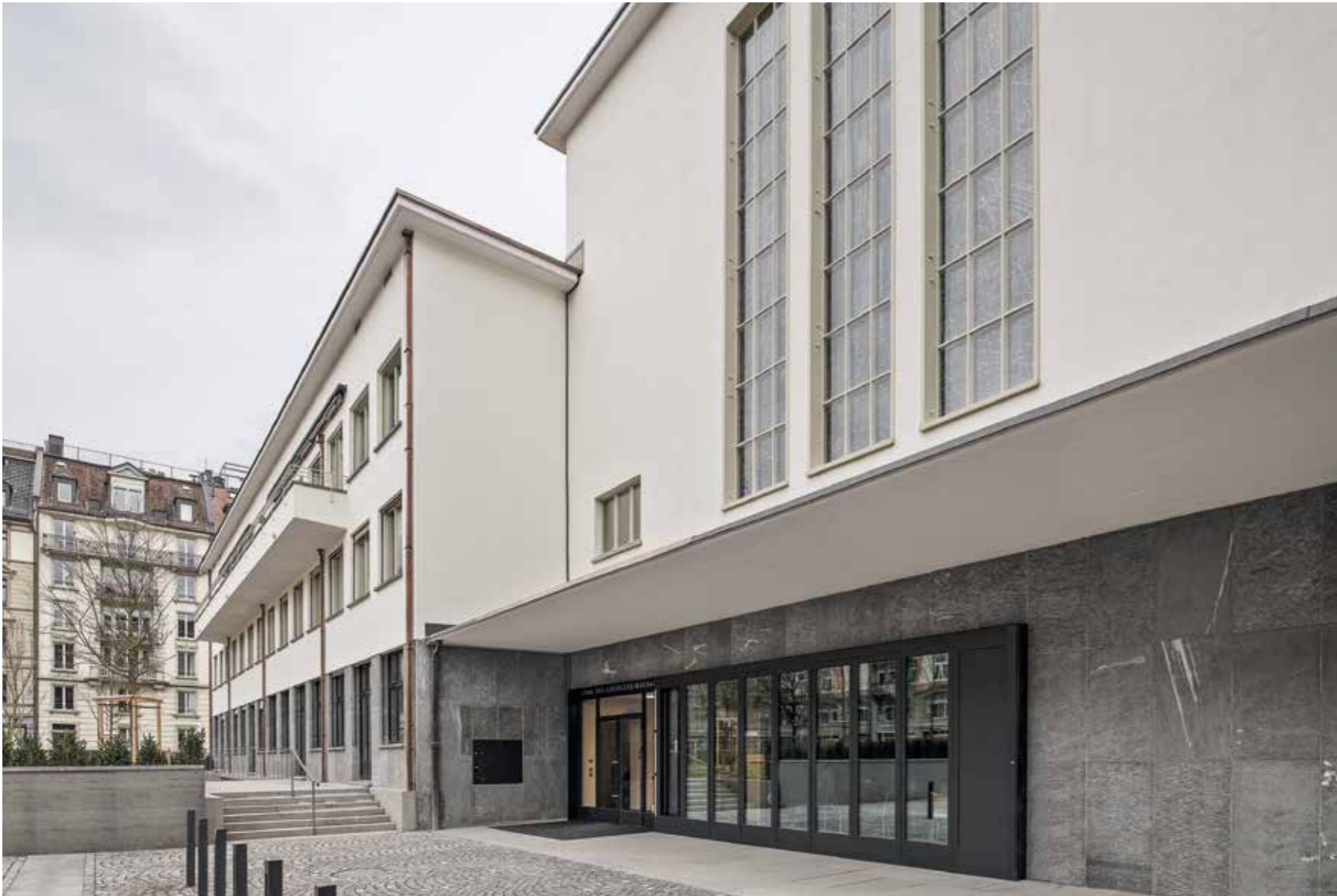
Von der Eingriffstiefe der Sanierung ist heute kaum mehr etwas zu sehen. Die substanziellen Eingriffe wirken selbstverständlich und massvoll.
