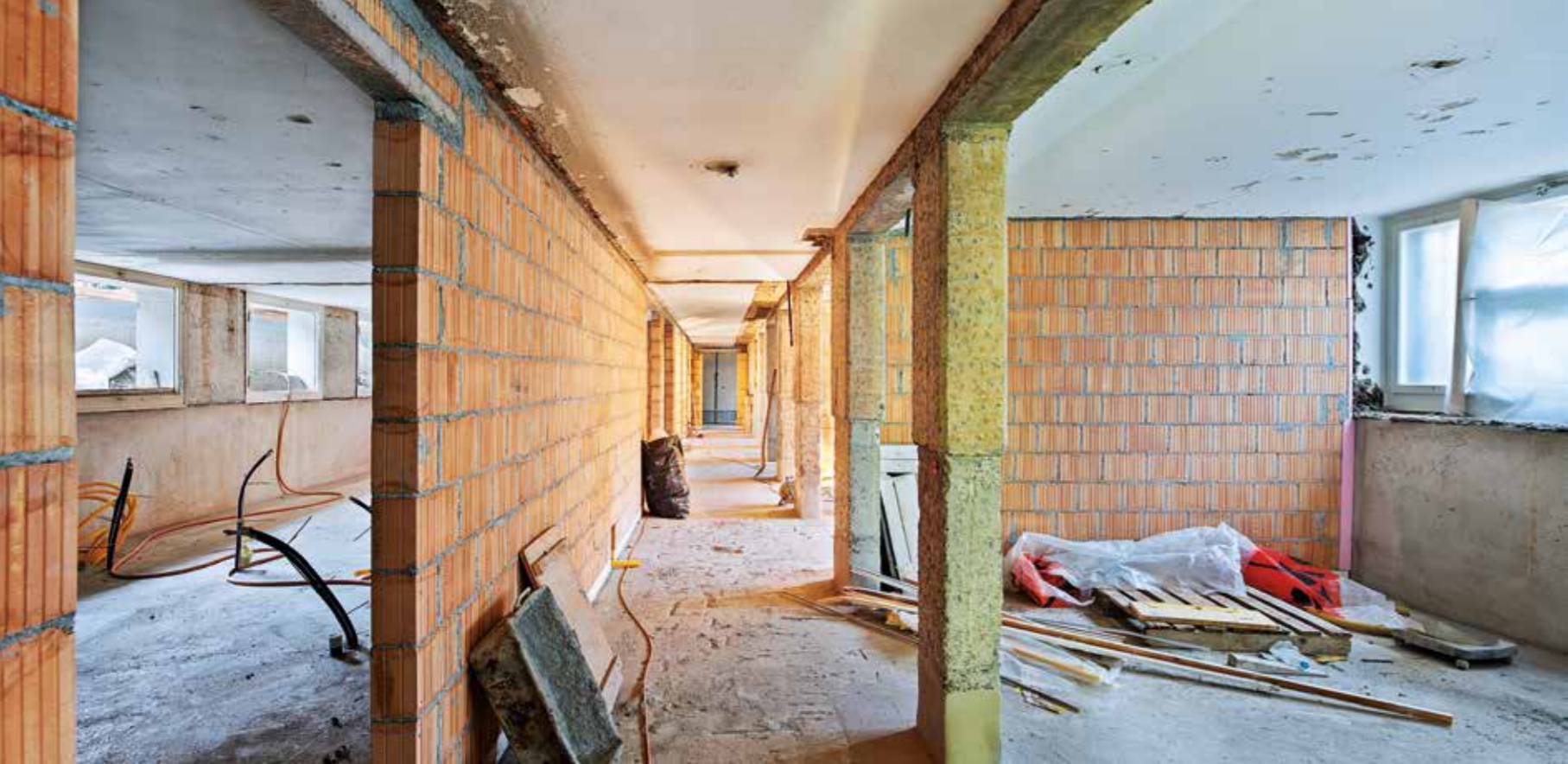
Die Zwischenwände wurden frisch aufgemauert und die Installationen neu gezogen.
