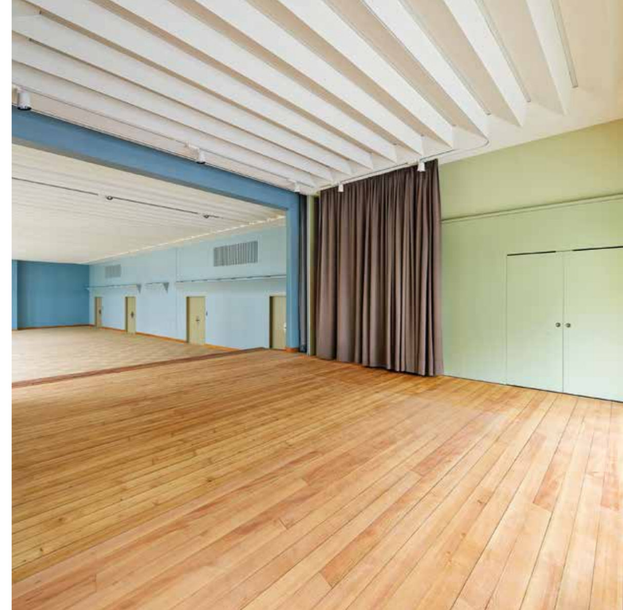
Der neue Bühnenraum kann im neuen Setup in vielfältiger Weise genutzt werden: im Alltag als Cafeteria, für Veranstaltungen aller Art und natürlich auch als Bühnenraum. Die Belichtung des Raumes wurde - wie die Vorhangschienen - in die neu aufgebaute Akustikdecke integriert. Diese stellt aufgrund ihre komplexen Geometrie und Oberfläche eine gute Akustik bei unterschiedlichen Betriebsanforderungen des Raumes sicher.
