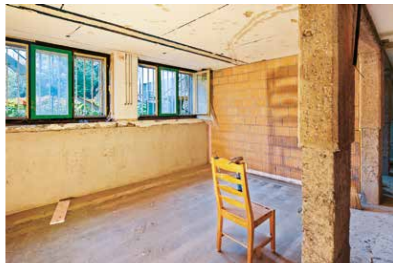
Die Zwischenwände wurden frisch aufgemauert und die Installationen neu gezogen.
