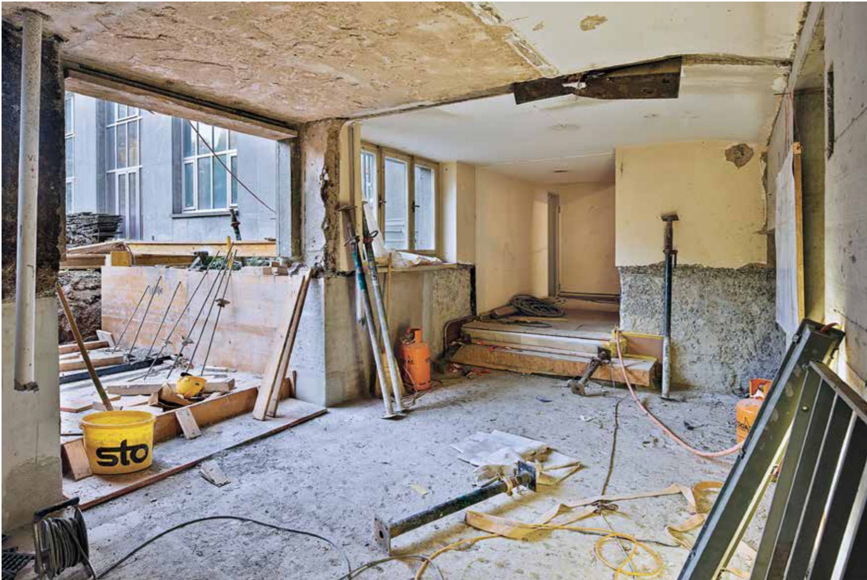
Das Ausmass der Umbaumaassnahmen lässt sich in diesen Bildern erahnen. Im Gartengeschoss wurden die Wände bis auf die Grundstruktur entfernt und das ganze Geschoss wurde bis unter die Fensterbrüstung abgedichtet.
