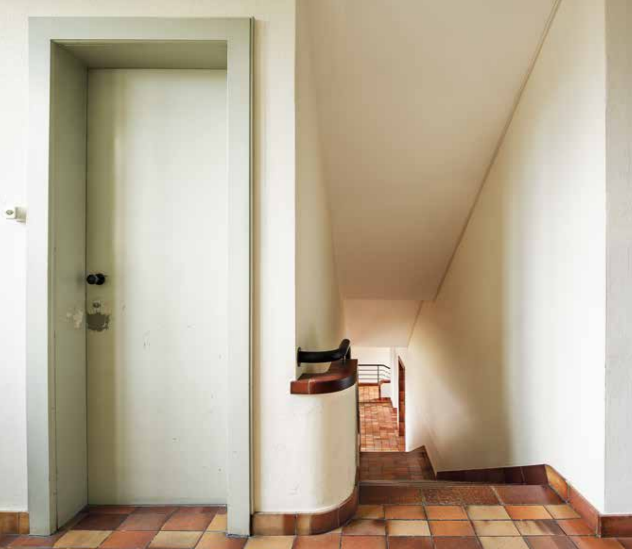
Der Zugang zum neu erstellten Dachgeschoss wird ermöglicht durch den Abbruch der Wandscheiben.
