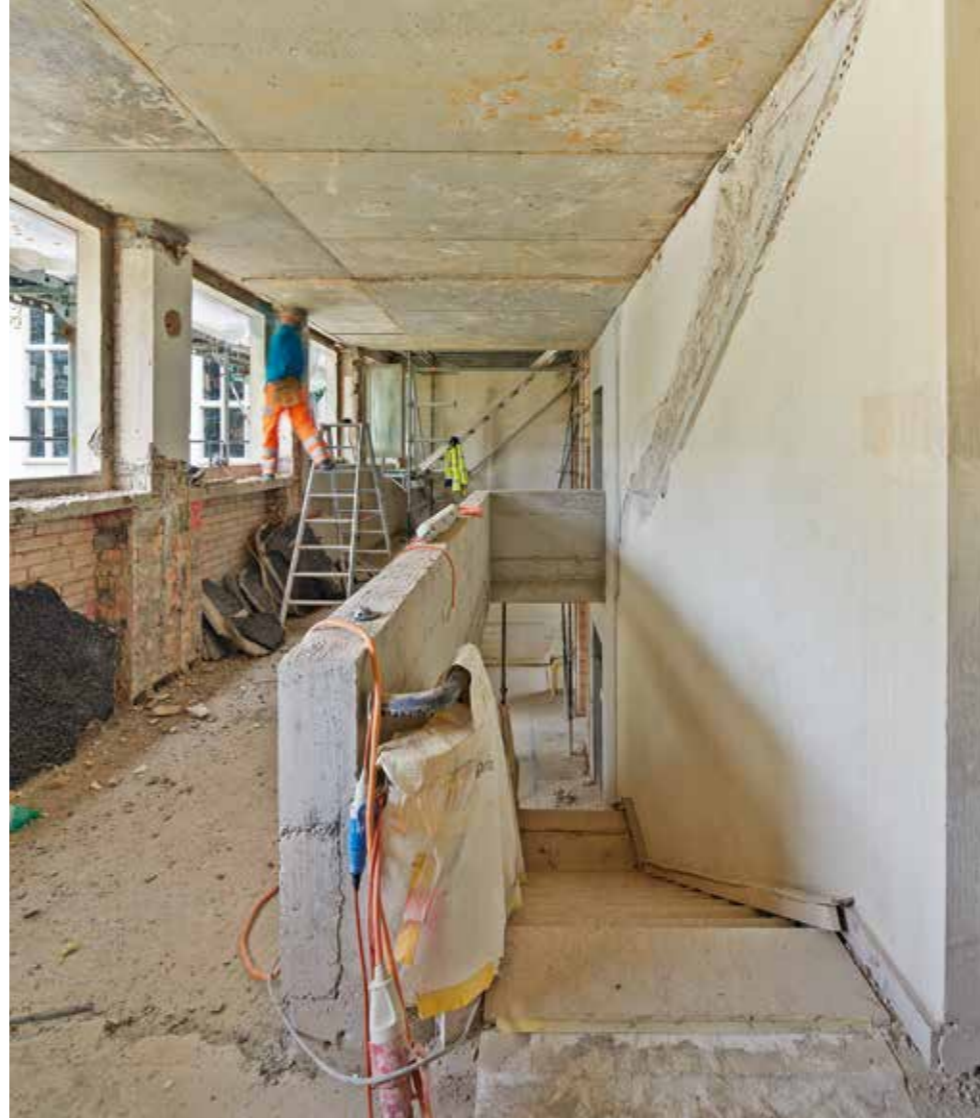
Der Abbruch des zweiten Treppenaufgangs erforderte aufwendige bauliche Massnahmen. So musste ein Stahlbetonobergurt, der nun als Geländerbrüstung in Erscheinung tritt, eingezogen werden, um die Stabilität der Decke zu gewährleisten.
