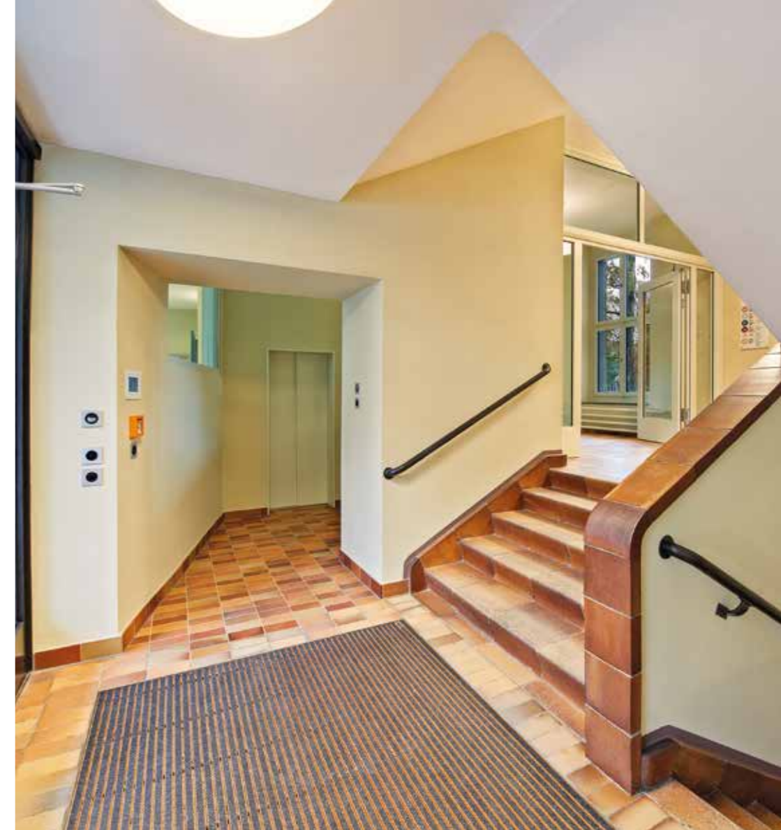
Im fertigen Zustand erscheint der Raum, als wäre er schon immer so da gewesen - nur wirkt er nun frischer und wärmer. Steinzeugplatten, Handläufe und Treppen wurden in aufwendiger Arbeit den heutigen Anforderungen angepasst, sind aber gleichzeitig ihrem ursprünglichen Wesen nachempfunden. Der neu eingebaute, den Anforderungen an Barrierefreiheit entsprechende Lift hat die Besonderheit einer Über-Eck-Türöffnung. So können die Geschosse jeweils auf der richtigen Seite durch den Lift erschlossen werden.
