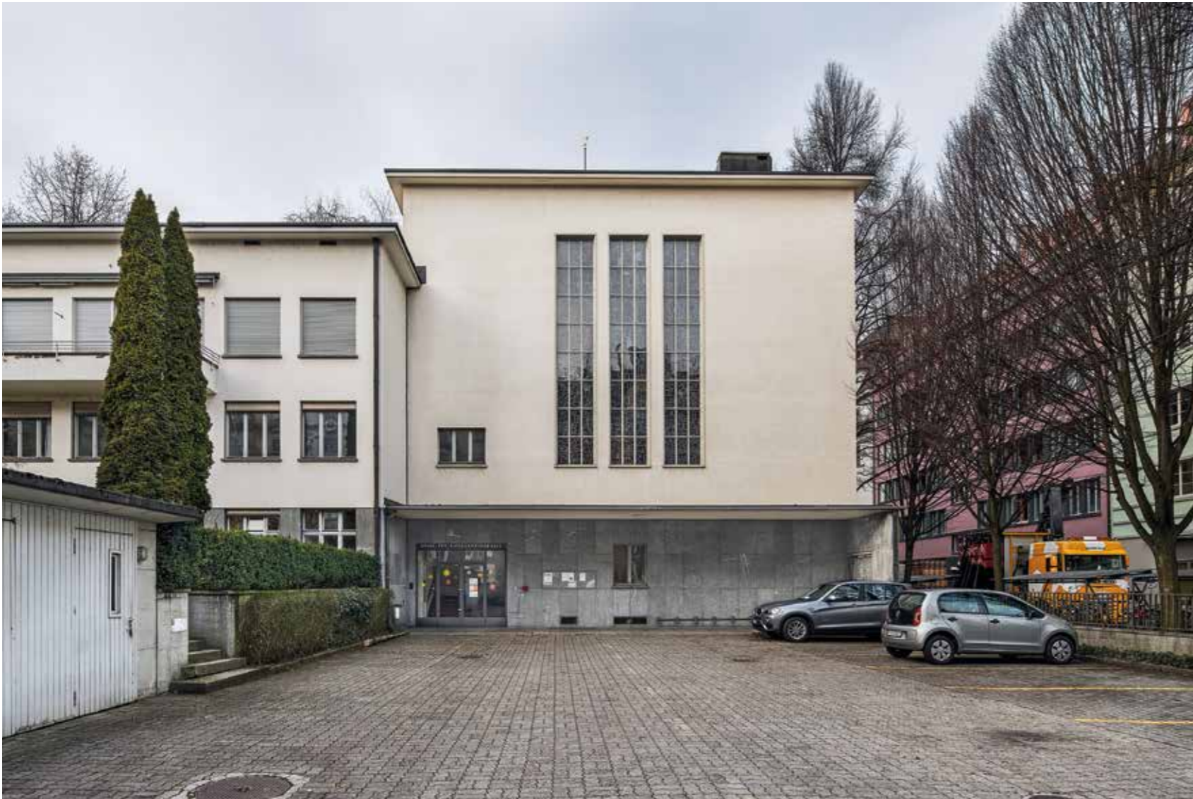
Der Zugang von der Murbacherstrasse zum Kirchgemeindehaus vor der Gesamt-sanierung (links) und nach der Sanierung (rechts). Der Zugang wurde grosszügiger gestaltet und verbindet den Innen- mit dem Aussenraum. Die Oberflächen wurden in ihrer Qualität aufgewertet.
