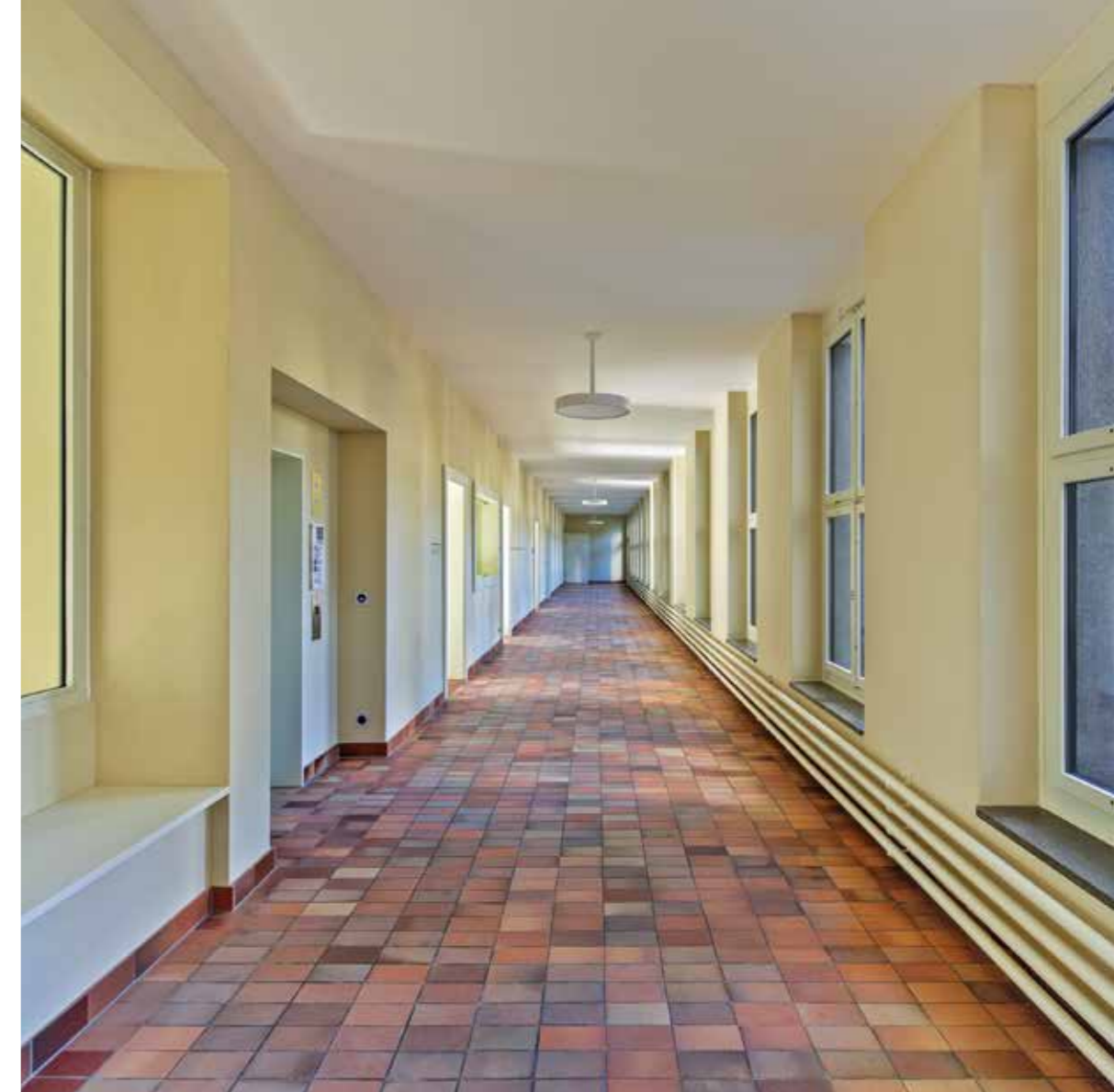
Alt und Neu im frischen Gewand: Der Korridor im sanierten Zustand mit dem ursprünglichen Klinkerboden. Das Farbkonzept hält sich an die Farbkaviatur des Ursprungszustandes. Trotzdem wirkt die Vorzone zum Sekretariat, zum Lukastreff und zum Zwinglisaal zeitgemäss und strahlt Wärme und Harmonie aus.
